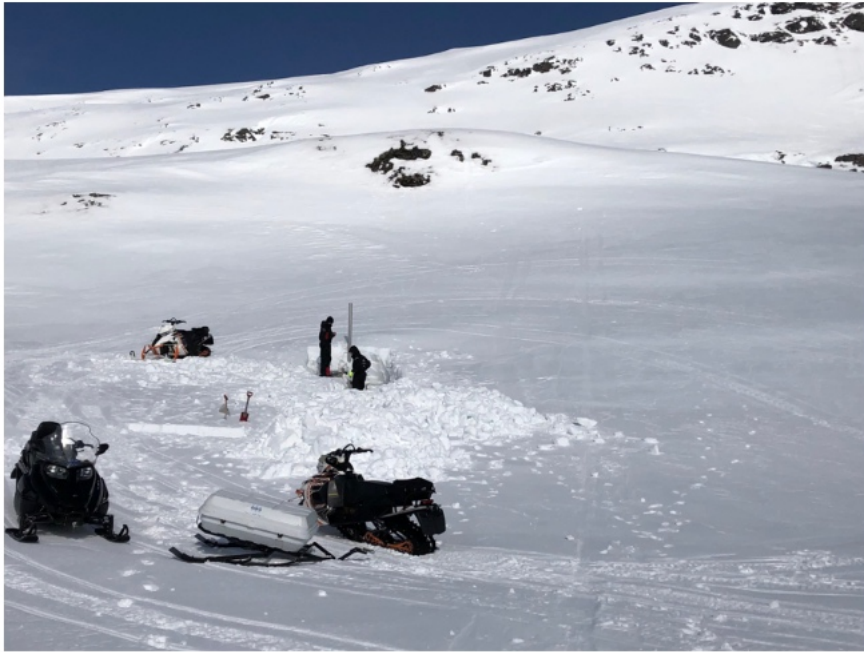
Her grever ansatte i SKS Produksjon Sulitjelmaverkene seg ned til luftesjakten ved Storelvvatn kraftverk. Det er mai måned og seks meter ned til bakkenivå.
