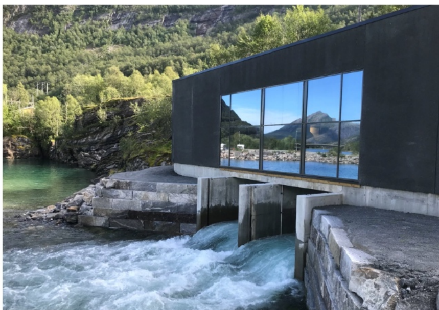
Nye Sjøfossen kraftverk (23 GWh) ble satt i drift høsten 2020
